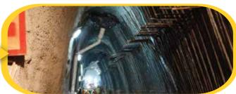
En la siguiente etapa se concreta la demolición y excavación de la parte central y se construye la losa del techo para fortalecer la parte superior del túnel.
