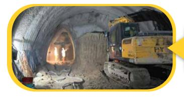
Se empieza por excavar manualmente los laterales del túnel, conformando lo que se conoce como ojivas. Durante esta etapa, la parte central del túnel sirve como base para garantizar la estabilidad del terreno y de la superficie.
